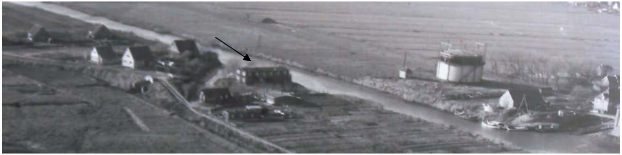
Luftbild vom Bootshausgelände im Herbst 1956
